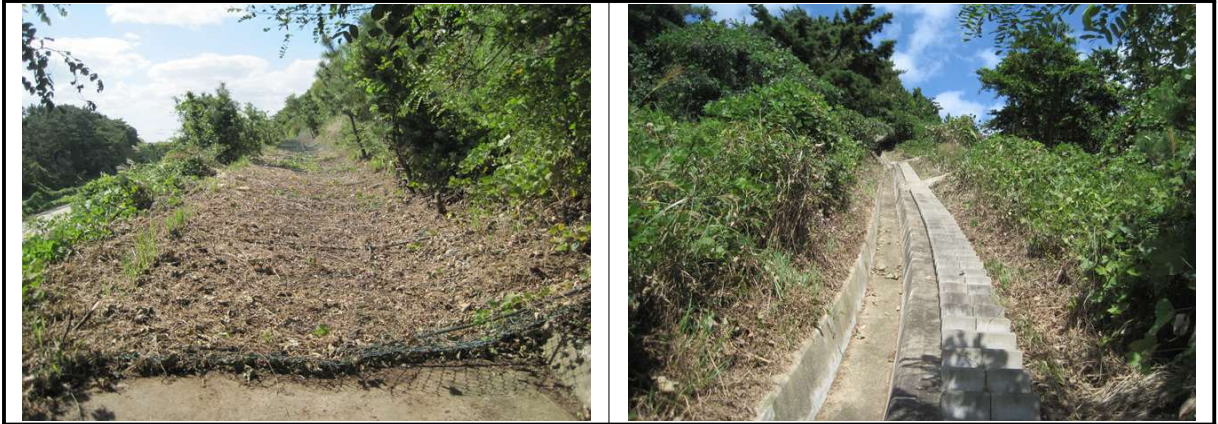
【그림 3.3.3】 배수시설 전경
