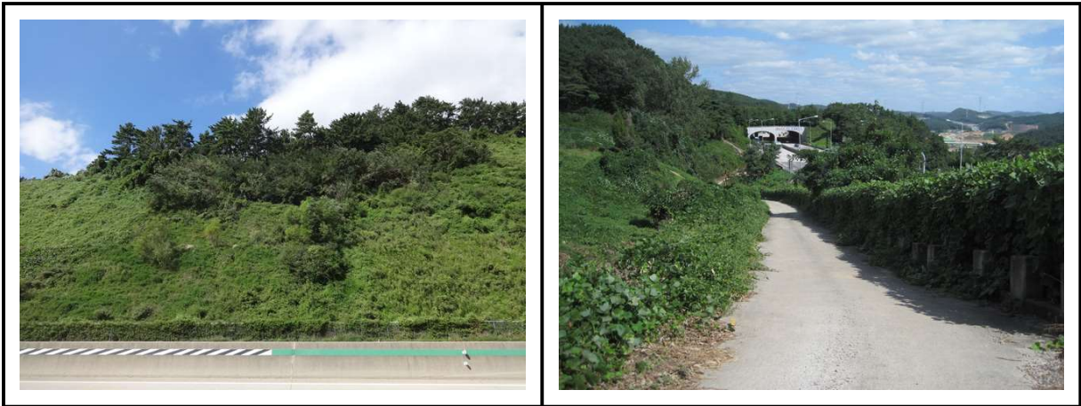
【그림 3.3.1】 상부자연사면 전경
